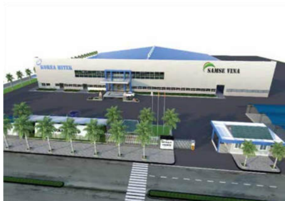
Nhà máy SAMSE VINA Lô CN5, Cụm Công nghiệp Cầu Yên, P. Ninh Phong, Tp. Ninh Bình SAMSE VINA Factory Lot CN5, Cau Yen Industrial Cluster, Ninh Phong Ward, Ninh Binh City
